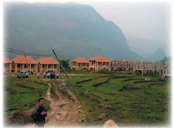
Anfang 2007 sind schon einige der massiven Herbergen fertiggestellt.
